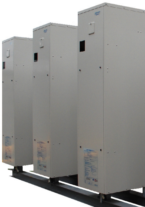
蓄熱部 (3 ユニット連携の近景)
