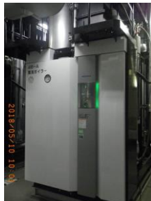
貫流ボイラー
