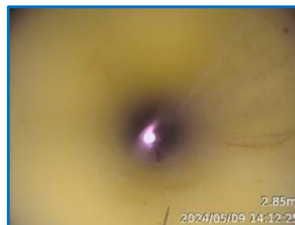
PE 管内調査状況
