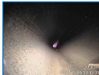
铸铁管内調査状況
