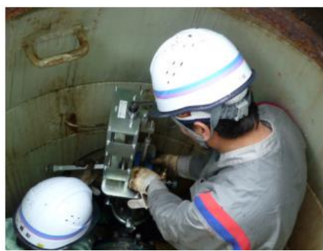
バルブピット内施工状況
