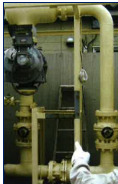
ガスメーター・配管内 ガス処理現場例
