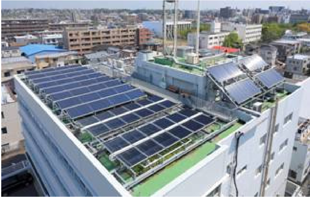
東京ガス中原ビル（ソーラークーリングシステムのデモプラント）
