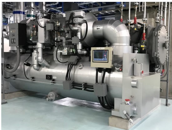
電動ターボ冷凍機
