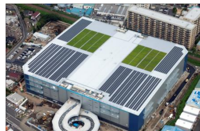
神奈川・中山屋上ソーラ発電所
