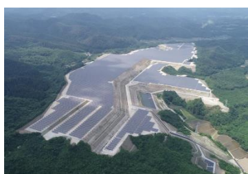
宮城・黒川メガソーラー発電所
