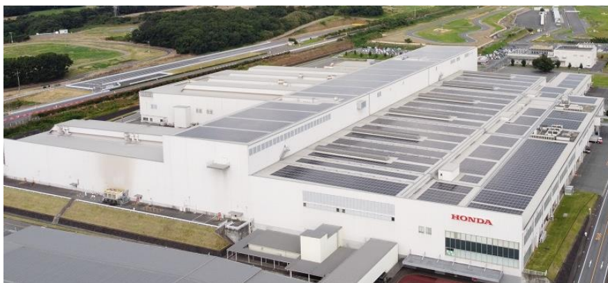
Honda 熊本製作所への太陽光発電パネル設置状況
