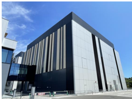
エネルギーセンター外観 (中央監視室は 24 時間 365 日常駐)
