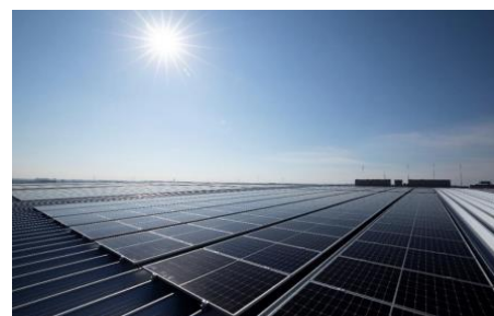
T-LOGI 久喜の屋根に設置された太陽光パネル
