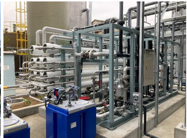
水のサイクルを可能にする排水回収装置（ROユニット）
